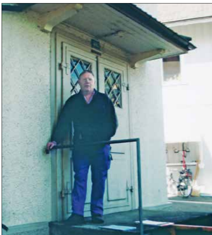
Kari Hofmann bei der Trafostation Bachthalen.
