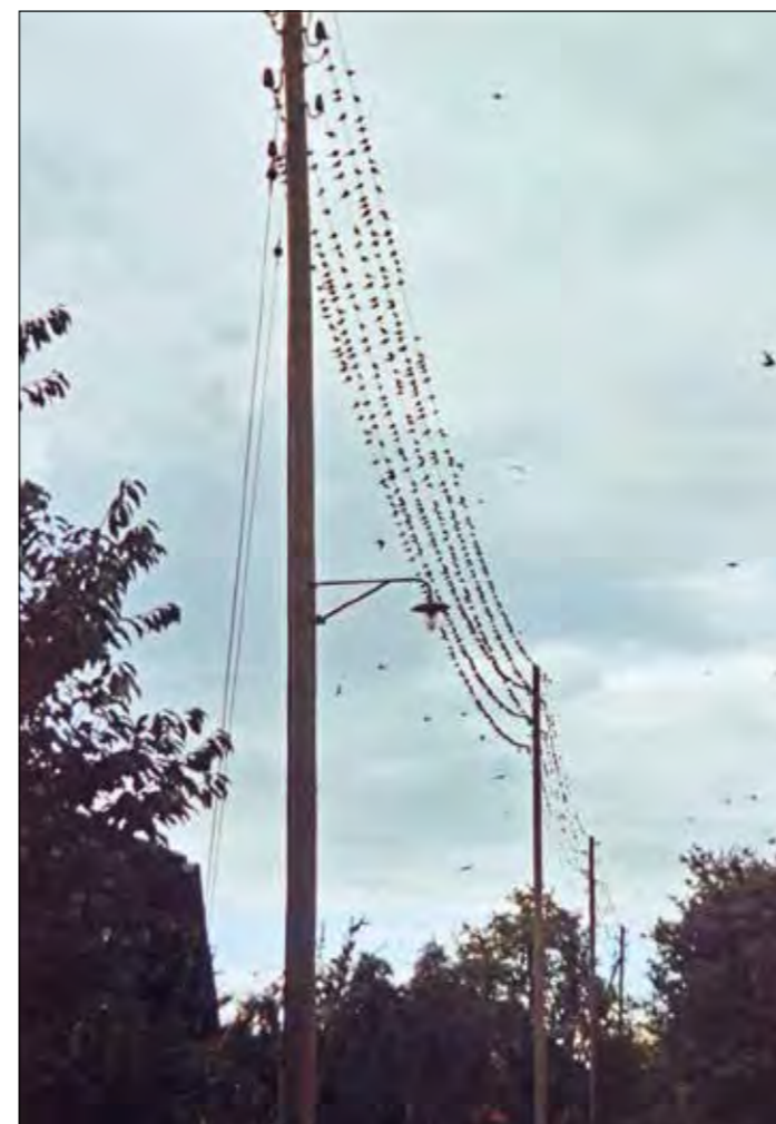
Weisch no? Freileitungen mit Vogelschwarm.
