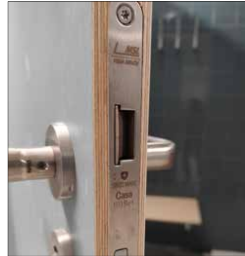
Der Türriegel, welcher nicht mehr raussteht.
