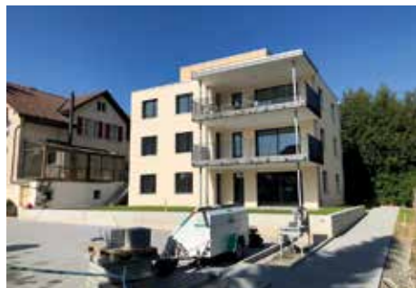
Grundstück nachher - mit Mehrfamilienhaus Neubau
