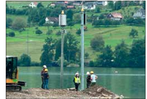
Die alte Leuchte (links) wird durch die neue ersetzt (Bild: Ueli Haller).
