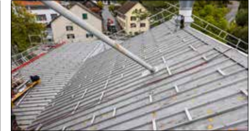
Vorbereitungen auf dem Dach, um die Panels zu montieren.
