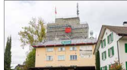
Die Montage der rund 270 Solarpanels ist in vollem Gange.
