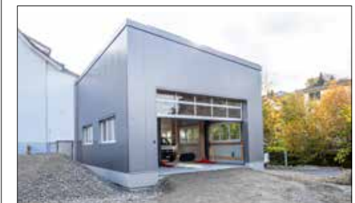
Der neue Werkhallen-Anbau.
