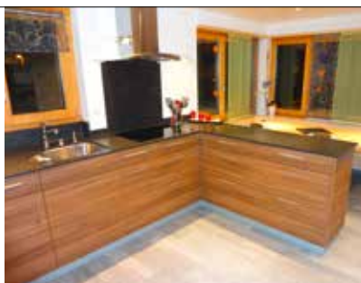
Küchenbau und Geräte-Ersatz
