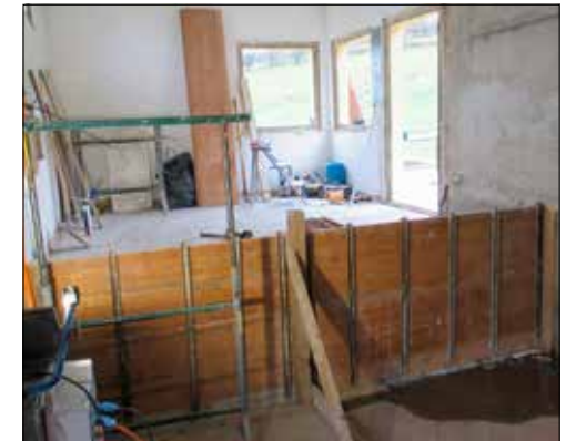
Maurerarbeiten im Maschinenhaus.
