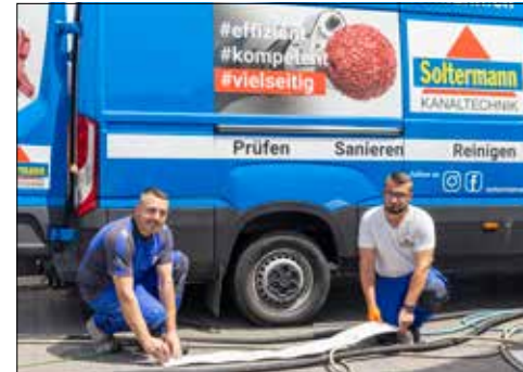
Vorbereitung des Inliners durch das Kanaltechnik-Team.
