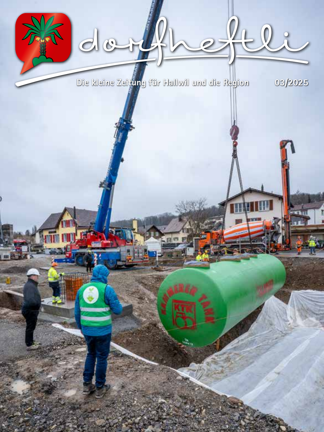
Titelbild: Tanksetzung für die neue Tankstelle
