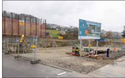
Der Aushub an der Seetalstrasse 52 ist bereits in vollem Gange.
