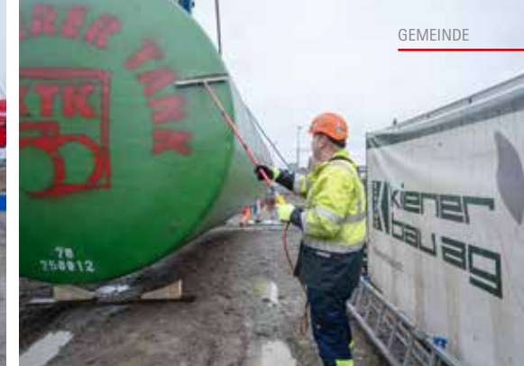
Der 16-Tonnen-Tank wird vorsichtig vom Tieflader gehievt und vor dem Versenken nochmal auf seine Dichtigkeit geprüft.
