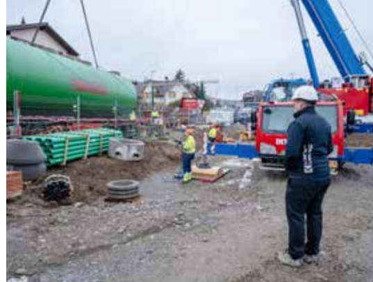
Der 16-Tonnen-Tank wird vorsichtig vom Tieflader gehievt und vor dem Versenken nochmal auf seine Dichtigkeit geprüft.
