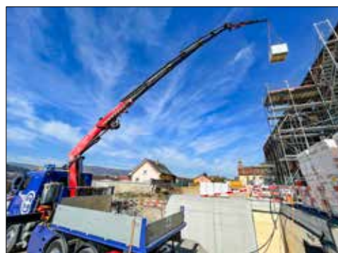
Mit Kran und Fingerspitzengefühl geht es hoch hinaus.
