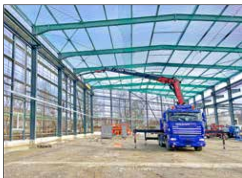
Der Kran im Einsatz bei der Kaltbandhalle in Reinach.
