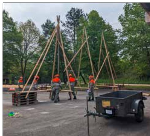
Zivilschützer beim Brückenbau in Eiken.
