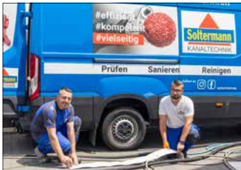
Vorbereitung des Inliners durch das Kanaltechnik-Team.
