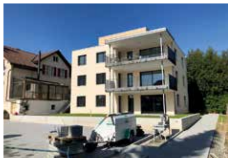
Grundstück nachher - mit Mehrfamilienhaus Neubau
