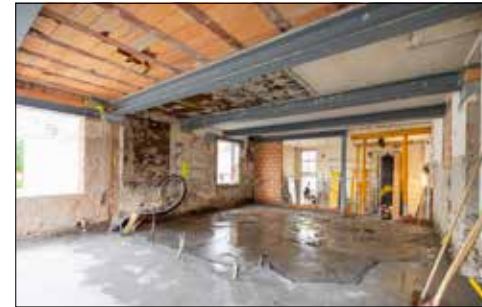
Der neu entstandene Verkaufsraum ohne tragende Innenwand.
