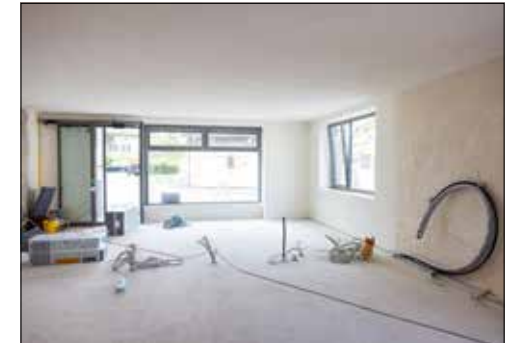
Der Verkaufsladen ist vorbereitet für den Einbau des Tresens.
