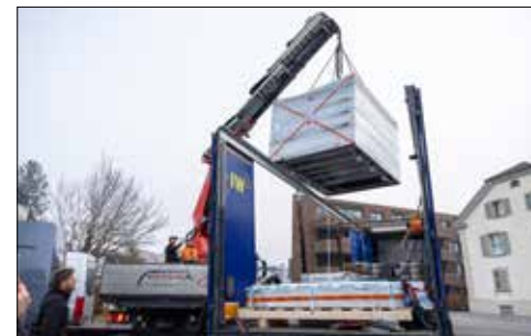
Umladen des sechs Tonnen schweren Ofens auf den mobilen Kran.
