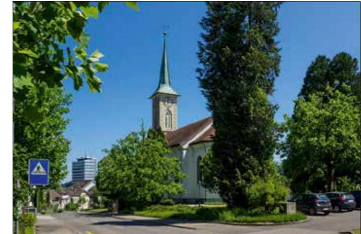
Der Menziker Kirchturm soll wieder in neuem Glanz erstrahlen.
