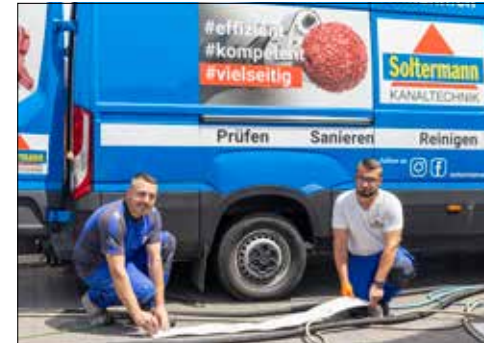
Vorbereitung des Inliners durch das Kanaltechnik-Team.
