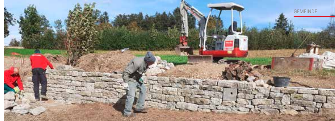
Stein für Stein entstand die Trockenmauer im Gebiet Trolerhof, wo Profi Jonas Wassmann von Mitgliedern des NVMB unterstützt wurde.
