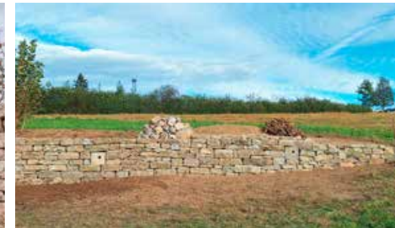
Stein für Stein entstand die Trockenmauer im Gebiet Trolerhof, wo Profi Jonas Wassmann von Mitgliedern des NVMB unterstützt wurde.
