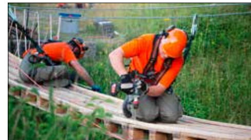
... und beim Errichten der Brücke.
