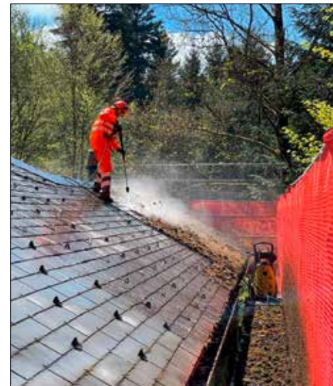
Zivilschützer befreit das Dach von Moos.
