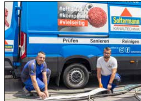
Vorbereitung des Inliners durch das Kanaltechnik-Team.
