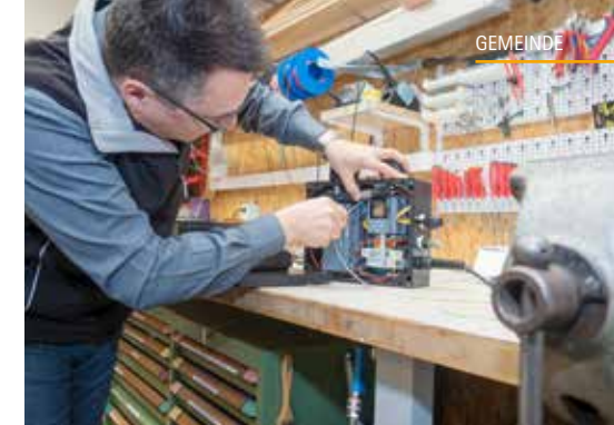
Verdrahtung einer Steuerung in der hauseigenen Werkstatt.
