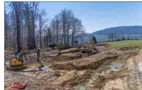
Die Inbetriebnahme ist für März 2021 vorgesehen. Ebenfalls im März ist der Rückbau des alten Reservoirs geplant. Dessen Kammern waren nicht mehr vollständig dicht und der nicht mehr zeitgemässe Zugang in die Kammern erfolgte von oben über eine Leiter. Dies entsprach nicht mehr den Anforderungen an die Arbeitssicherheit. Zudem entspricht das alte Reservoir nicht mehr dem heutigen Lebensmittelgesetz. Mit einer Sanierung und Vergrösserung hätten keine Kosteneinsparungen erzielt werden können.
