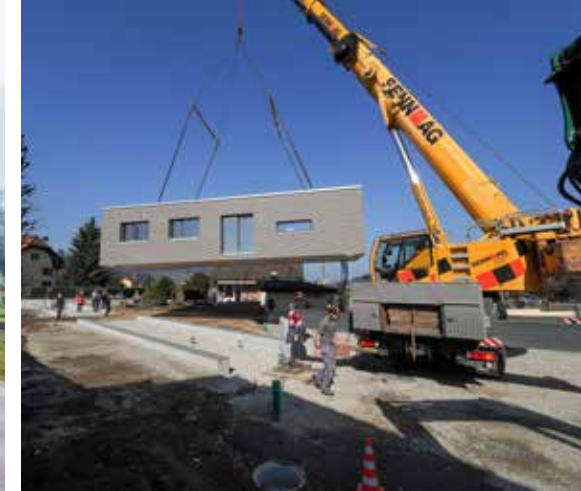
Modulhaus Nummer 1 schwebt sicher am Kranhaken.
