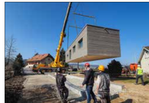
Modulhaus Nummer 2 wird auf das Fundament gesetzt.
