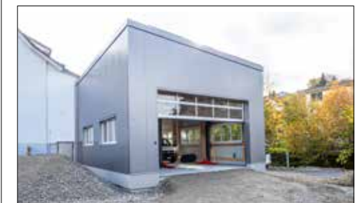
Der neue Werkhallen-Anbau.
