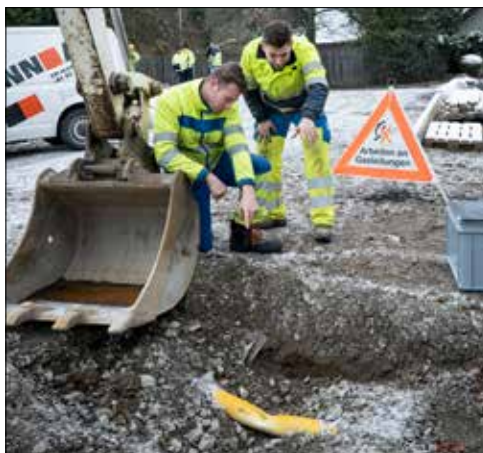
Zwei EWS-Mitarbeiter beurteilen die Lage bei der «lecken Gasleitung» und leiten entsprechende Sofortmassnahmen ein.
