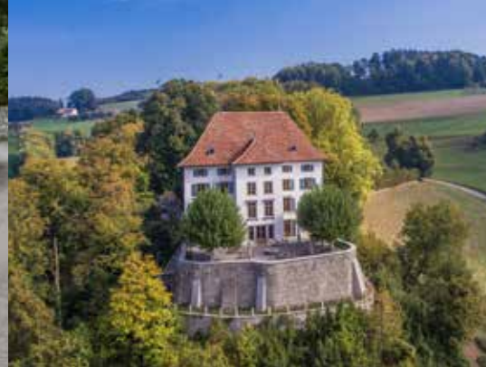
Dachsanierung beim Schloss Schlossrued.
