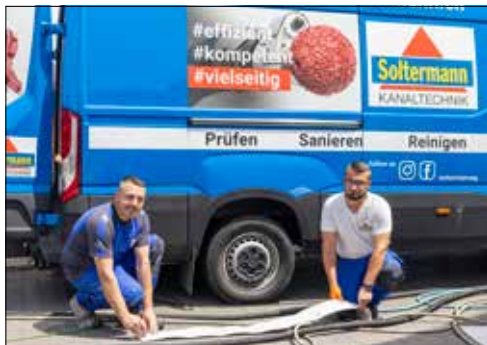
Vorbereitung des Inliners durch das Kanaltechnik-Team.
