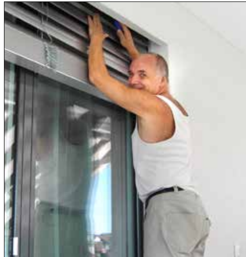
Kontrollarbeiten bei einer Lamellenstore.
