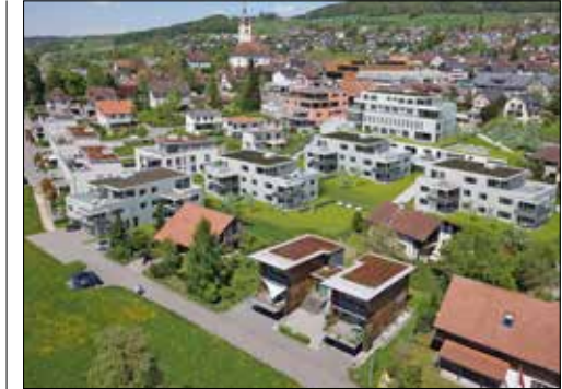
Gesamtüberbauung aus der Vogelperspektive.
