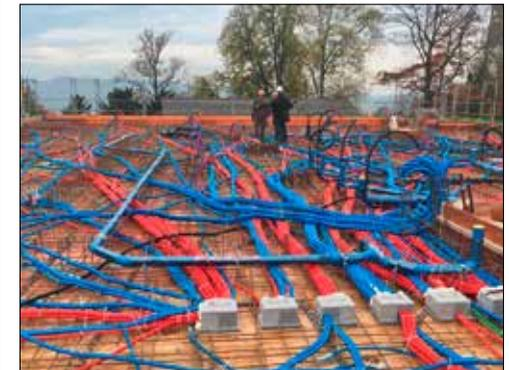
Bei 4 Kilometer Kabelrohren ist die Übersicht schwierig.
