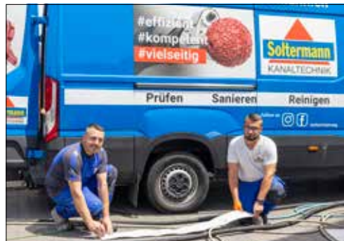
Vorbereitung des Inliners durch das Kanaltechnik-Team.
