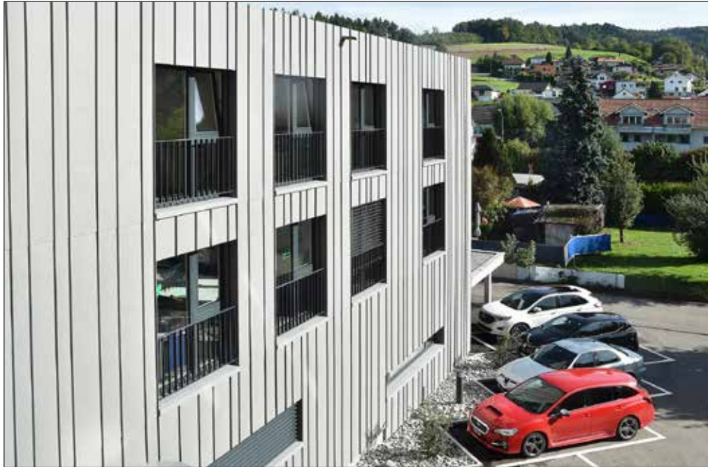
Spitex-Anbau des Alterszentrums Mittleres Wynental in Oberkulm.
