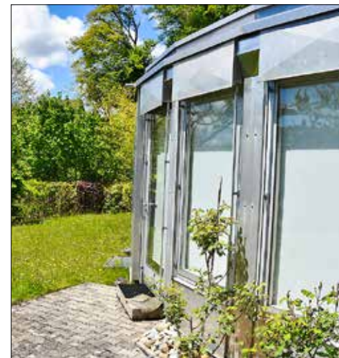
Die Aussenhülle besteht aus Fensterflächen und Aluminium.
