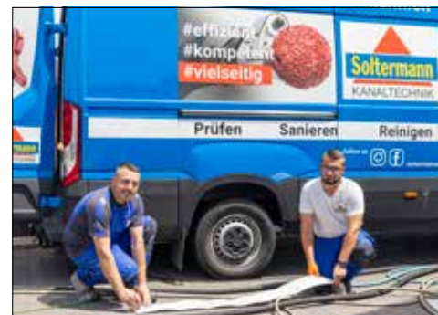
Vorbereitung des Inliners durch das Kanaltechnik-Team.
