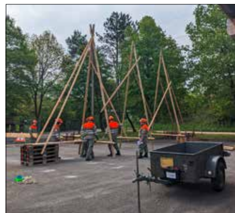
Zivilschützer beim Brückenbau in Eiken.
