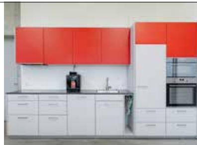
Küchenbau und Geräte-Ersatz
