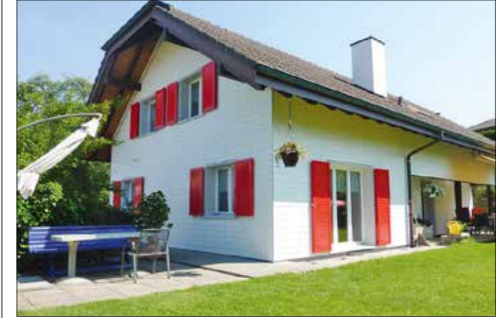
Neue Fassade: Schutz und Mehrwert für das Haus.
