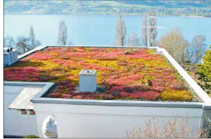
Flachdach mit zusätzlicher Begrünung.
