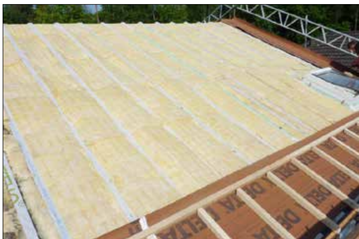
Dachisolation mit Glaswolle.
