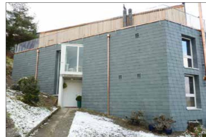
Eine gut isolierte Fassade ist die halbe Miete.
