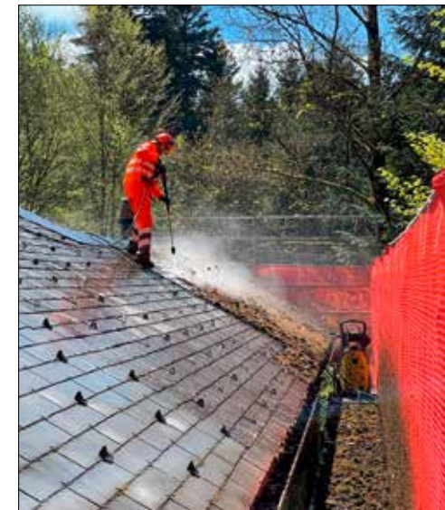
Zivilschützer befreit das Dach von Moos.
