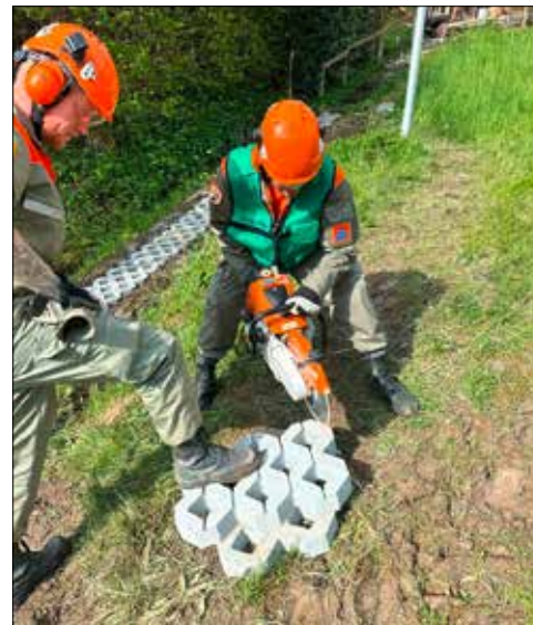
Zivilschützer beim Zuschneiden von Rasengittersteinen.
